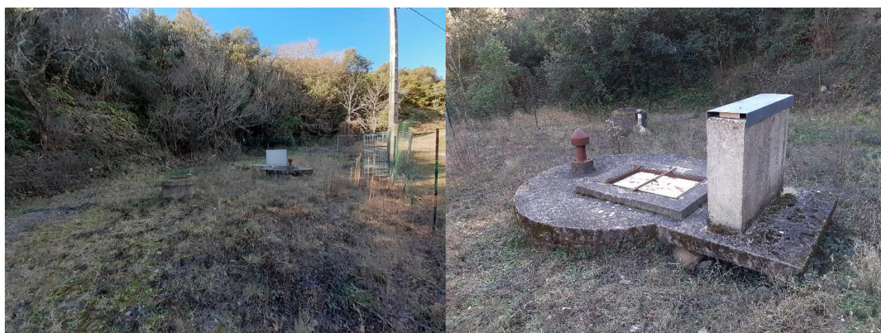
Figure 6 : Photographie de gauche : captage de Mas Rolland, l'accès depuis la route se fait par le chemin visible en arrière-plan à droite. Photographie de droite : au second plan la buse de captage de la source, au premier plan la bache de reprise avec le coffret électrique (photos F. Colas du 17/01/2022)
